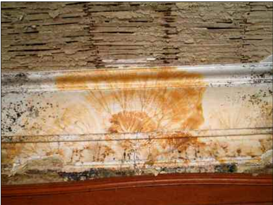
Figure 6. – Asterostroma cervicolor (= A. ochroleucum ), rhizomorphes et début de fructification (photo Protector Belgium).
