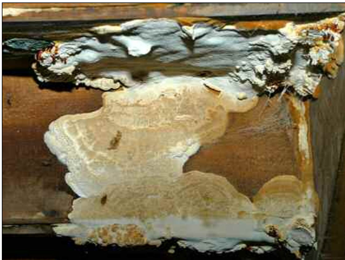
Figure 7. – Donkioporia expansa , jeune carpophore en cours de développement (photo Protector Belgium).
